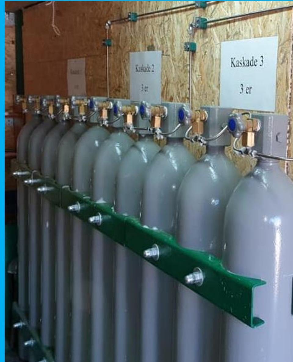
Eine neu aufgebaute Speicheranlage
