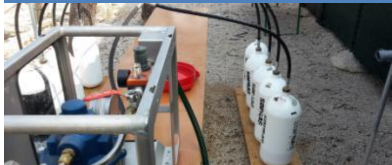
TROCKNUNGSANLAGE FÜR TAUSCHFLASCHEN
